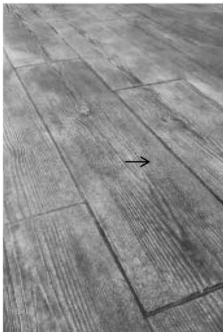
FIG. 3 – Revêtement de sol de « la terrasse des palmiers » Béton matricé imitation bois
