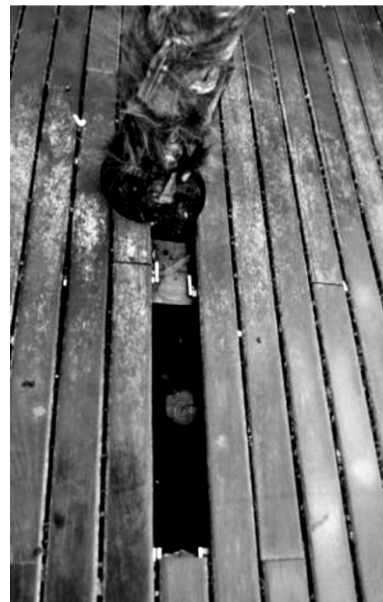
FIG. 2 – Lame de bois détériorée
